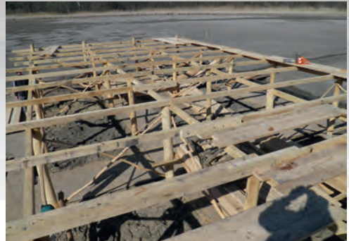
Zwischenstand beim Bau im Frühjahr 2014.
